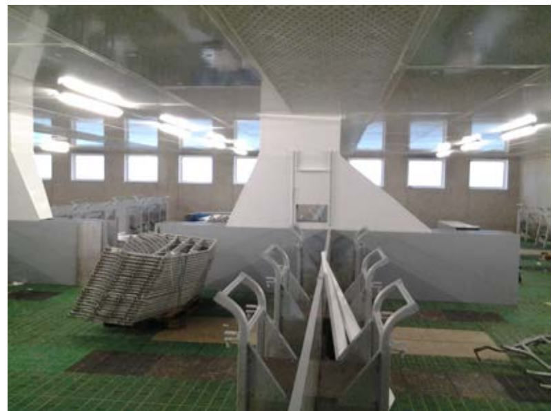
Verschiedene Teilunterflurabsaugungen (Kombination zwischen Unterflur- und Oberflurlüftung)
