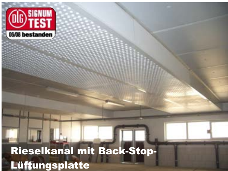
Rieselkanal mit Isoporenplatte (mit Komplettlochung od. Teil-perforierung)
