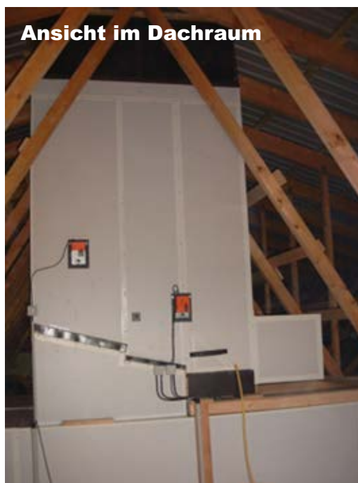
Tauschwäscher WVTW (Kombination Wärmetauscher und Luftwäscher)
