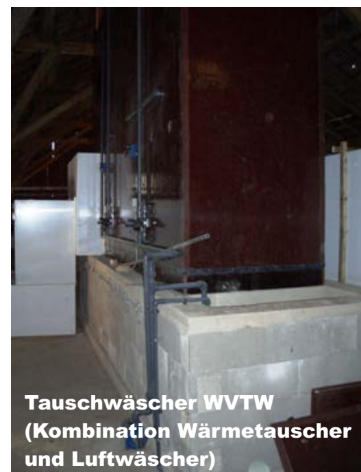
Wärmetauscher für Hackschnitzeltrocknung
